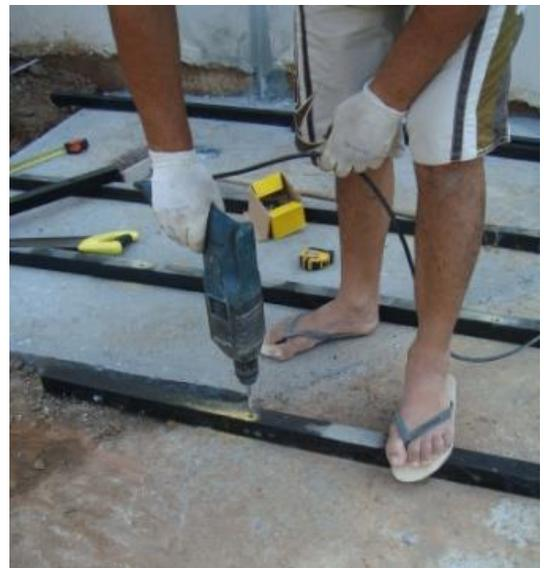
*Figura 10 – Falta de adequado equipamento de proteção (risco de acidente de trabalho).*
