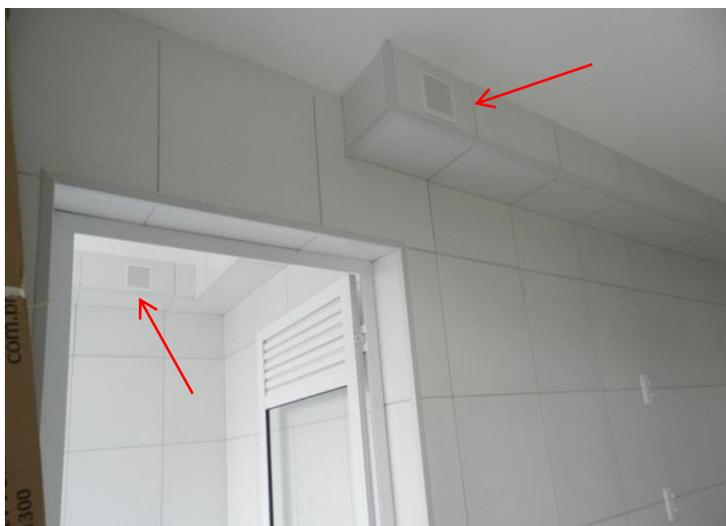
*Figura 2 – Sanca de acabamento do ramal de gás com sistema de ventilação adequado.*
