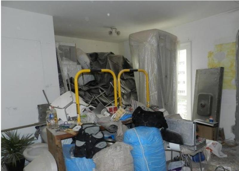
*Figura 3 – Acúmulo irregular de materiais onde deve ser verificada a carga sobre a laje, bem como a existência de materiais combustíveis e/ou inflamáveis*
