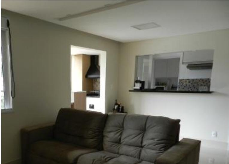
*Figura 8 – Abertura irregular da alvenaria estrutural para cozinha tipo americana.*
