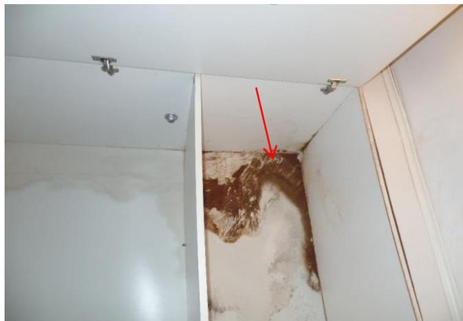
*Figura 11 – Presença de cupins detectada atrás do armário em área onde também foi registrada umidade na parede do shaft hidráulico.*
