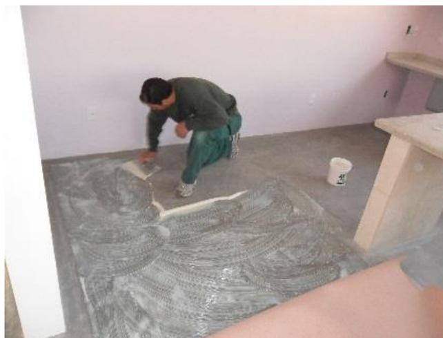
*Figura 5 – Aplicação da cola de aderência para fixação do piso (material inflamável).*
