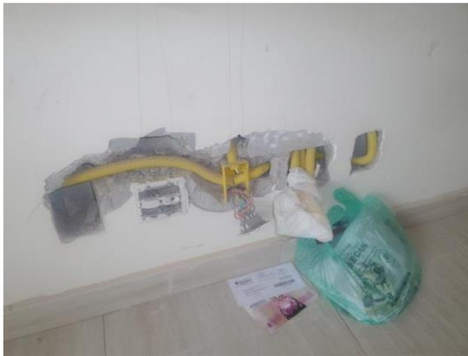
*Figura 6 – Abertura de rasgos nas paredes estruturais para passagem de infraestrutura de ar condicionado.*
