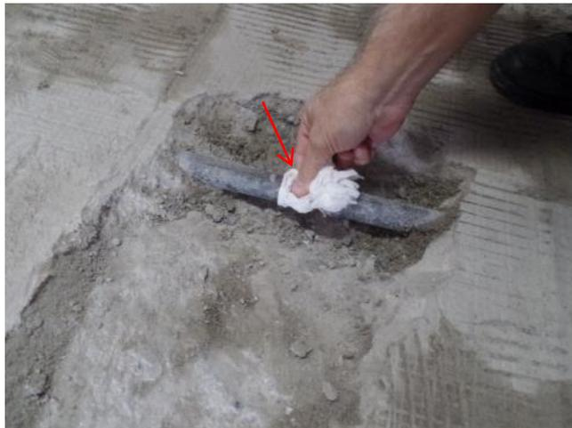
*Figura 4 - Rompimento do ramal de gás durante a demolição do piso.*
