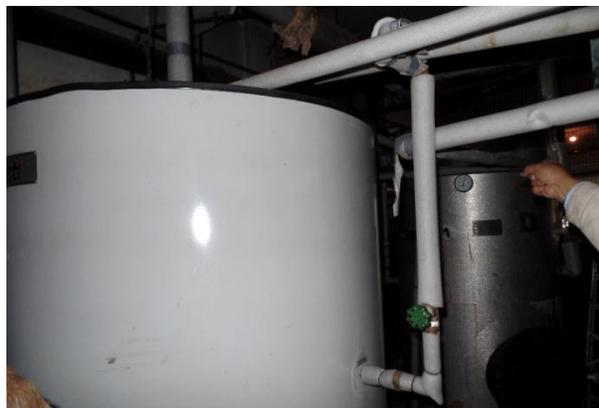
*Figuras 12, 13 e 14 – Remanejamento dos ramais hidráulicos que efetuaram a mistura entre os sistemas de água quente e fria, gerando perda de eficiência na alimentação geral dos apartamentos. Evento de difícil diagnóstico, sendo vistoriadas todas as unidades para checar o ponto de mistura dos sistemas.*
